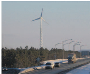
EnergiePGE 35kW turbine
